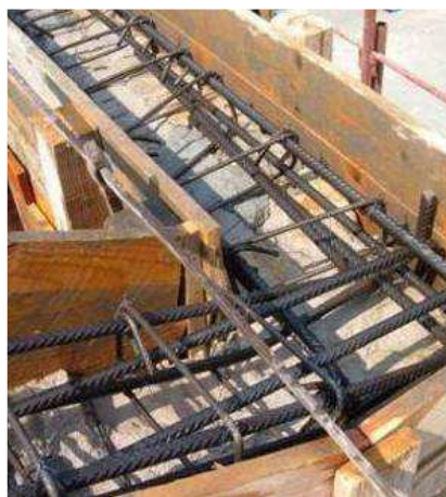
Slika 2.63 Vertikalni serklaž i horizontalni serklaž [4]
