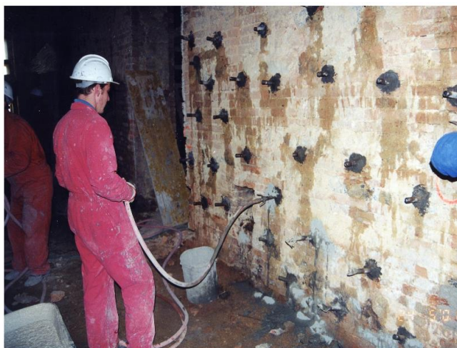
Slika 2.34 Fotografija izvedbe injektiranja zidova i prikaz učinka injektiranja na nosivost [12]
