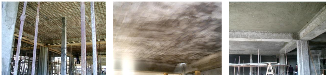
Slika 4.15 Postavljanje armature i torkreta s donje strane ploče [17]
