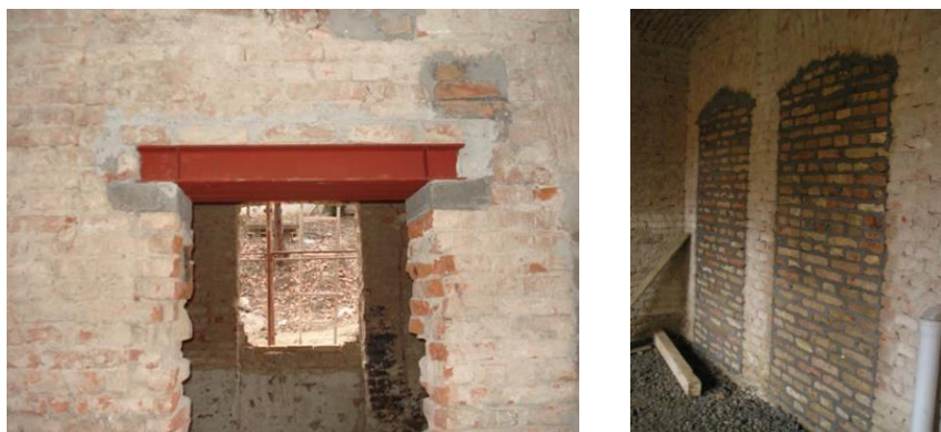
Slika 2.41 Zazidani otvor u zidu
