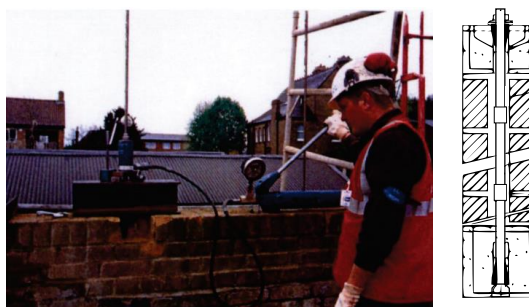
Slika 2.85 Prednapinjanje FRP užadima [8]
