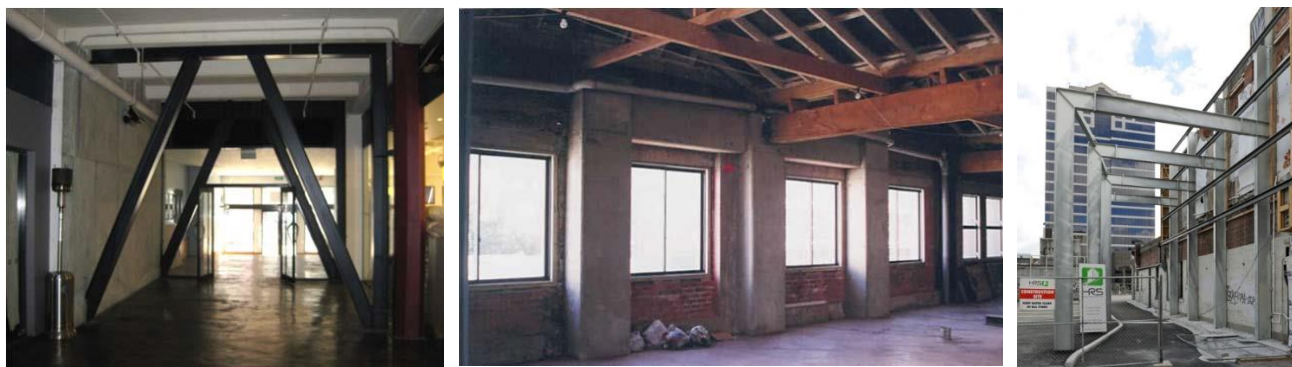
Slika 2.67 Pojačanje konstrukcije izvedbom čeličnih i AB okvira [4]
