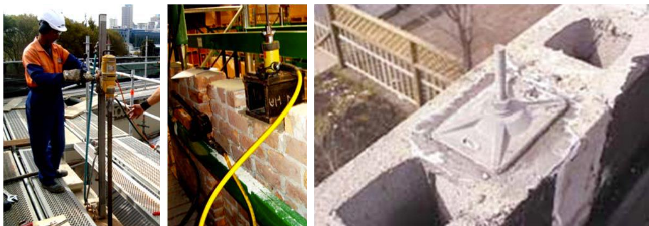
Slika 2.62 Prikaz izvedbe prednapinjanja [4]
