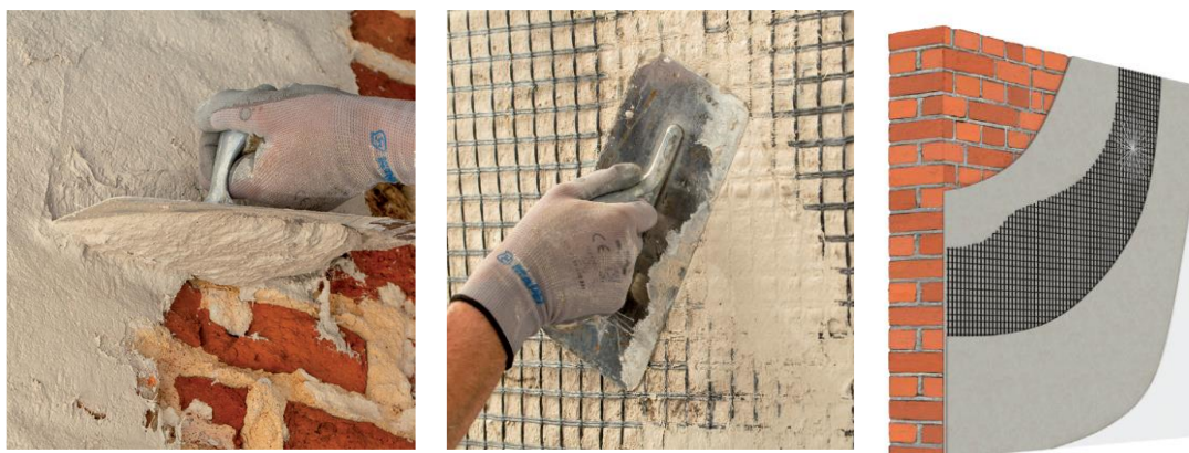
Slika 2.74 Pojačanje FRCM sustavom
