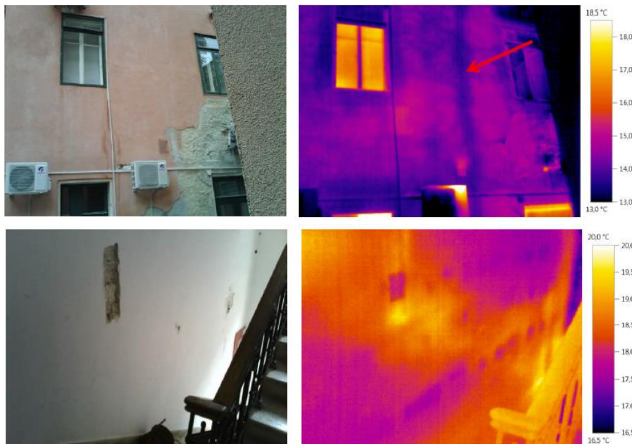
Slika 3.13 Prikaz snimljenih ploha zgrade i uočavanja skrivenih dijelova pomoću termokamere
