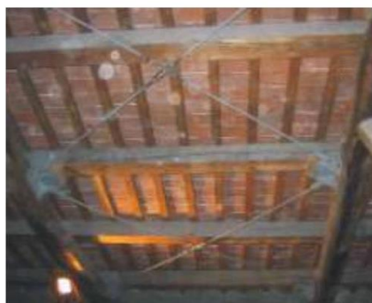
Slika 2.18 Horizontalna rešetka od metalnih traka ili FRP lamela
