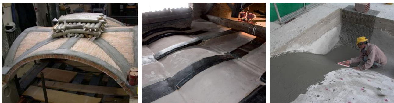
Slika 2.81 Prikaz izvedbe pojačanja svodova
