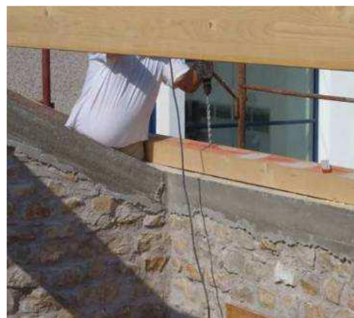
Slika 2.63 Vertikalni serklaž i horizontalni serklaž [4]
