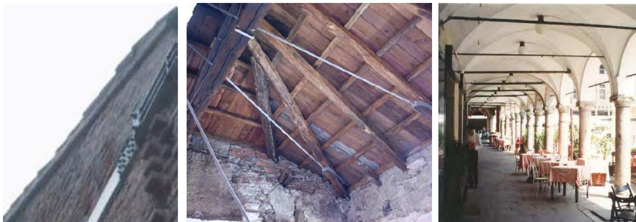
Slika 2.59 Izgled izvedenih pojačanja [4]
