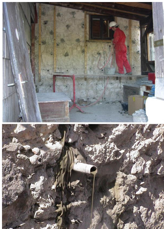
Slika 2.28 Postupak injektiranja zidanih zidova (lijevo) i fotografija injektiranja (desno) [12]
