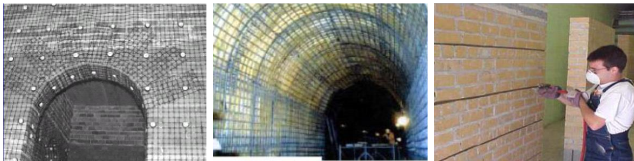
Slika 2.82 Primjeri pojačanja mrežama i šipkama
