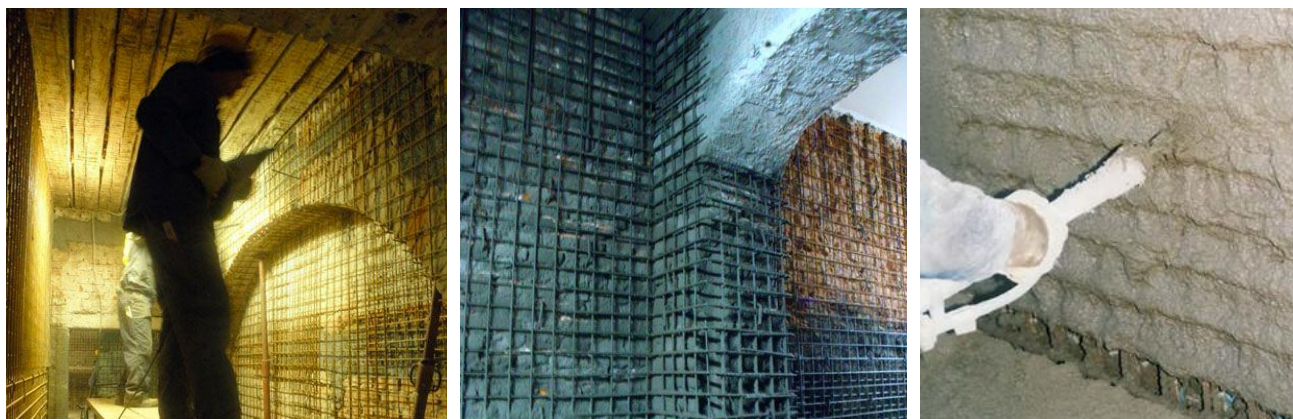
Slika 2.50 Fotografije izvedbe armiranobetonske žbuke (izvor: arhitekti.hr)
