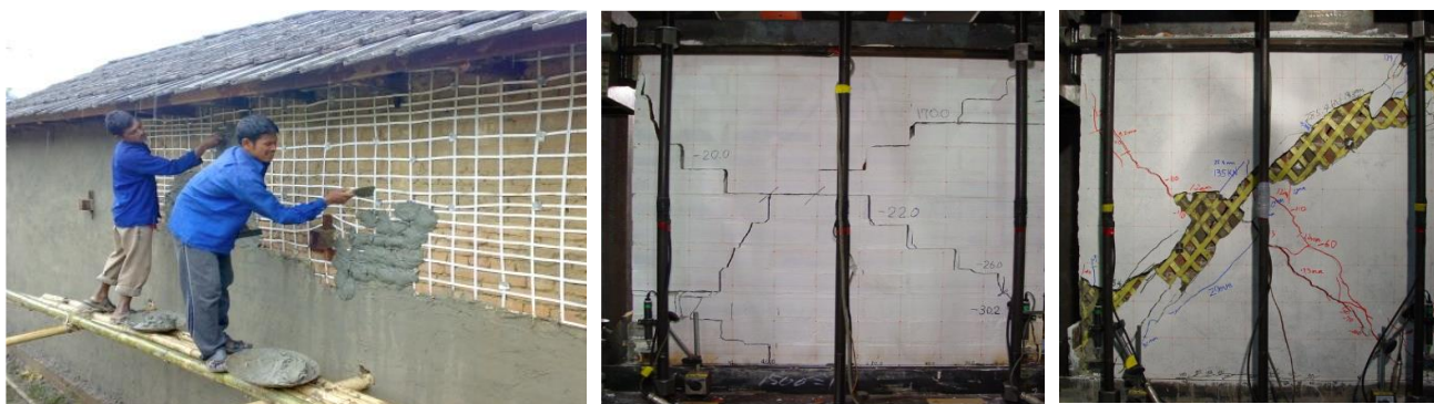
Slika 2.51 Pojačanje polipropilenskim mrežama [4]
