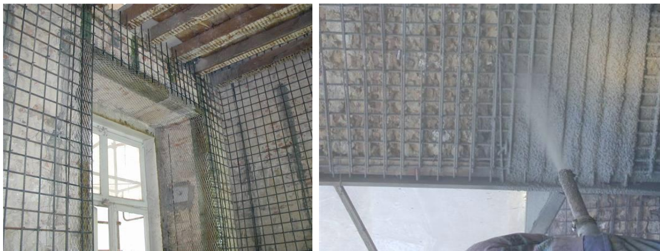
Slika 2.46 Pojačanje armiranim slojem betona [4]
