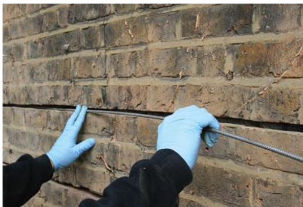
Slika 2.27 Postavljanje čeličnih šipki u popravljene sljubnice (izvor: falconstructural.co.uk)
