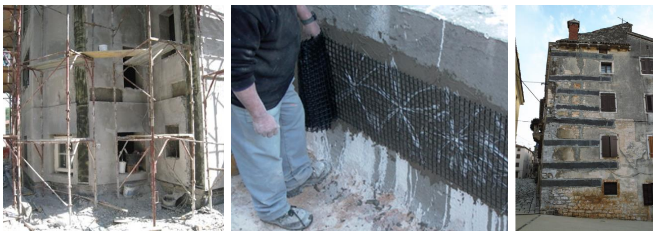
Slika 2.76 Prikaz izvedbe omatanja FRP trakama i FRCM sustavom
