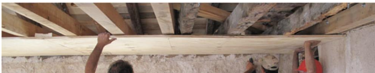
Slika 2.8 Postavljanje šperploče ispod grednih nosača [11]
