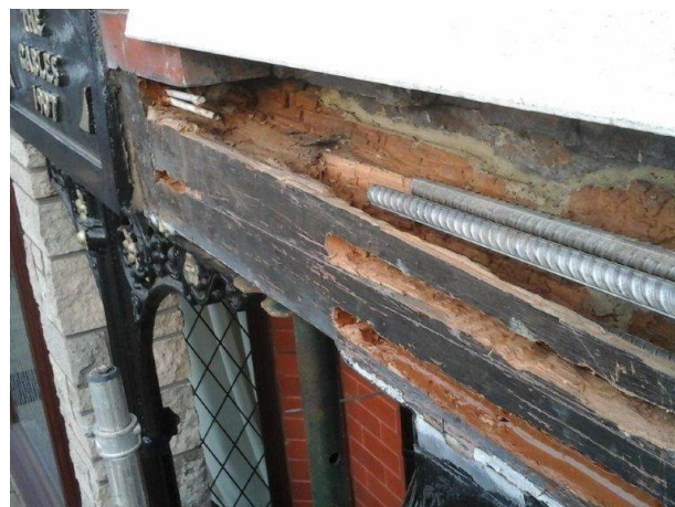
Slika 2.9 Sanacija drvenih greda čeličnim šipkama i epoksidnim mortom (izvor: protectahome.co.uk)
