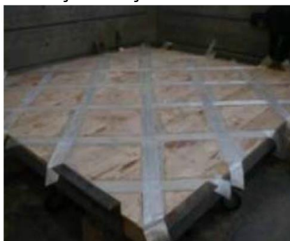
Slika 2.18 Horizontalna rešetka od metalnih traka ili FRP lamela
