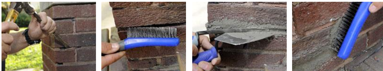
Slika 2.26 Postupak sanacije i izvedbe (izvor: falconstructural.co.uk)
